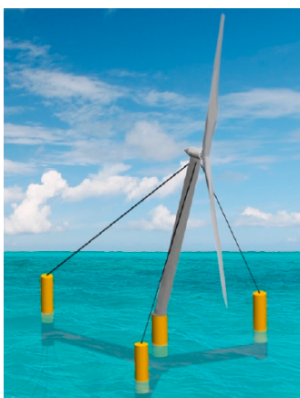
図 2.15: NEDO による一点係留式浮体式風車
